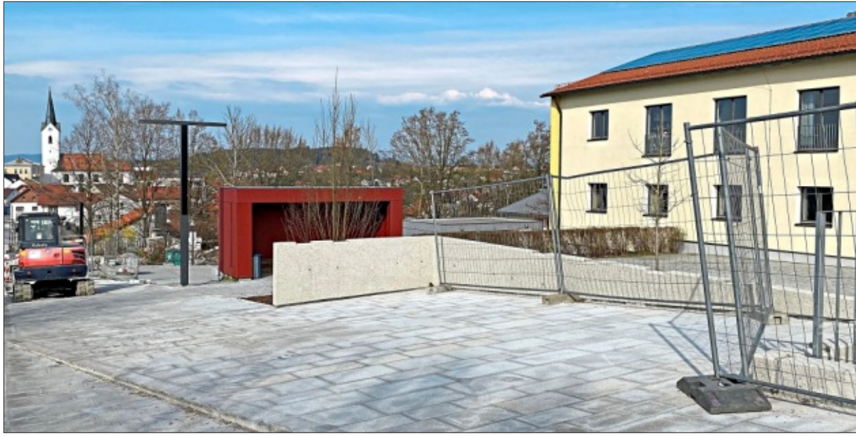
Bei der Grund- und Mittelschule wird ein Buswartehäuschen aufgestellt.
